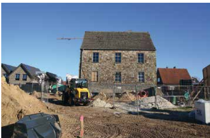
Nachdem die Inselmühle mehrere Jahrzehnte unbenutzt war, musste sie umfassend saniert werden. Nicht nur die Mühle selbst, auch der Außenbereich wurde dabei neu gestaltet. (Foto: Stadt Haren (Ems))
