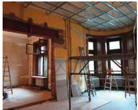
Abb. 8: Wanddurchbruch mit Stahlträger, Umbauarbeiten. (Foto: Malwine Kolary)
