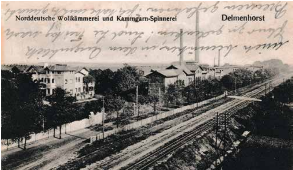
Blick auf das Lager der Norddeutschen Wollkämmerei und Kammgarnspinnerei (der Wasserturm fehlt noch, das Lager wurde noch nicht aufgestockt), ca. 1900. (Quelle: Nordwestdeutsches Museum für Industriekultur)
